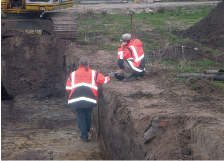
Afb. 4.1 Start werkzaamheden in werkput 1.
